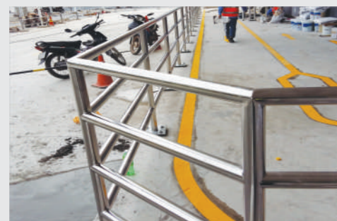
LAN CAN KHU ĐỂ XE HANDRAIL PARKING AREA
