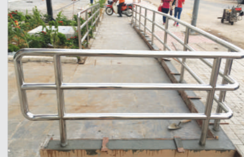
LAN CAN KHU ĐỂ XE HANDRAIL PARKING AREA
