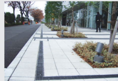
HỆ THỐNG MƯƠNG GUTTER SYSTEM
