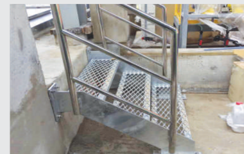
CẦU THANG THÉP STEEL STAIRCASE
