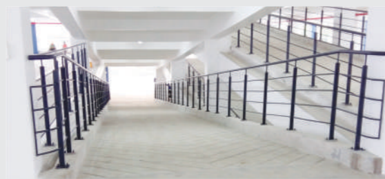
LAN CAN KHU ĐỂ XE HANDRAIL PARKING AREA
