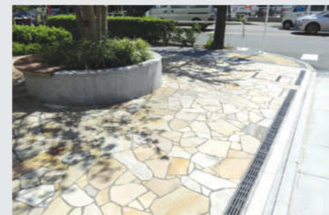
HỆ THỐNG MƯƠNG GUTTER SYSTEM
