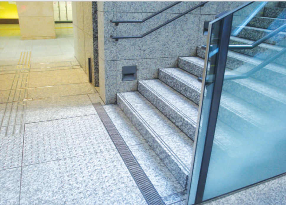
HỆ THỐNG MƯƠNG GUTTER SYSTEM
