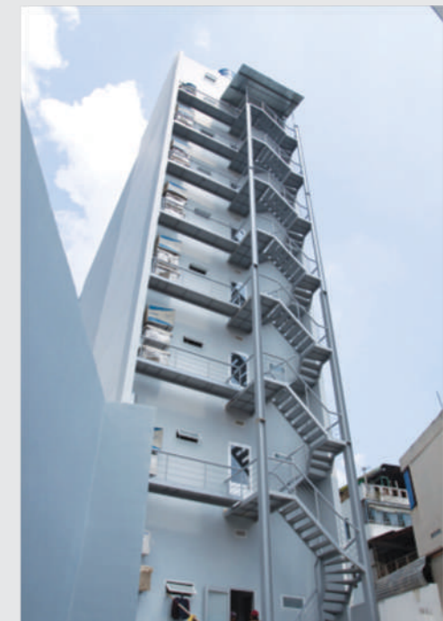
CẦU THANG THOÁT HIỂM ESCAPE STAIRCASE
