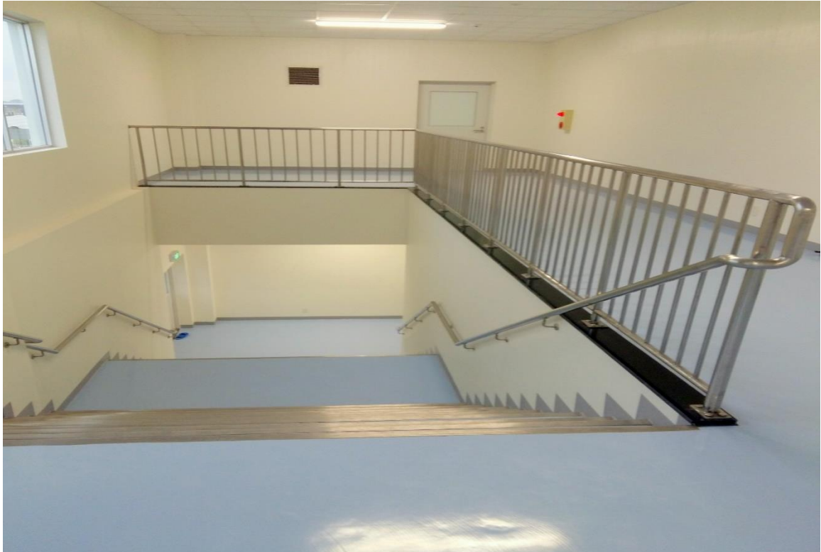
Hạng mục: Lan can inox- Dự án Nitori Bà Rịa Vũng Tàu
