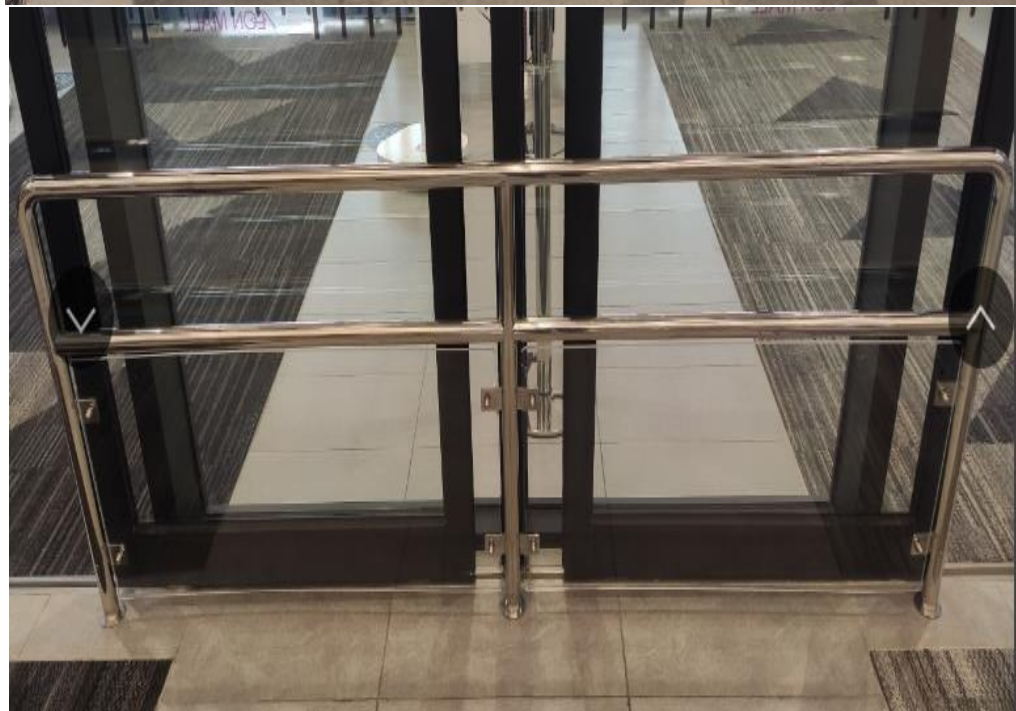
Hạng mục: Lan can bảo vệ cửa tự động- Dự án Aeon Hà Đông Category: Automatic door guard railing - Aeon Ha Dong Project
