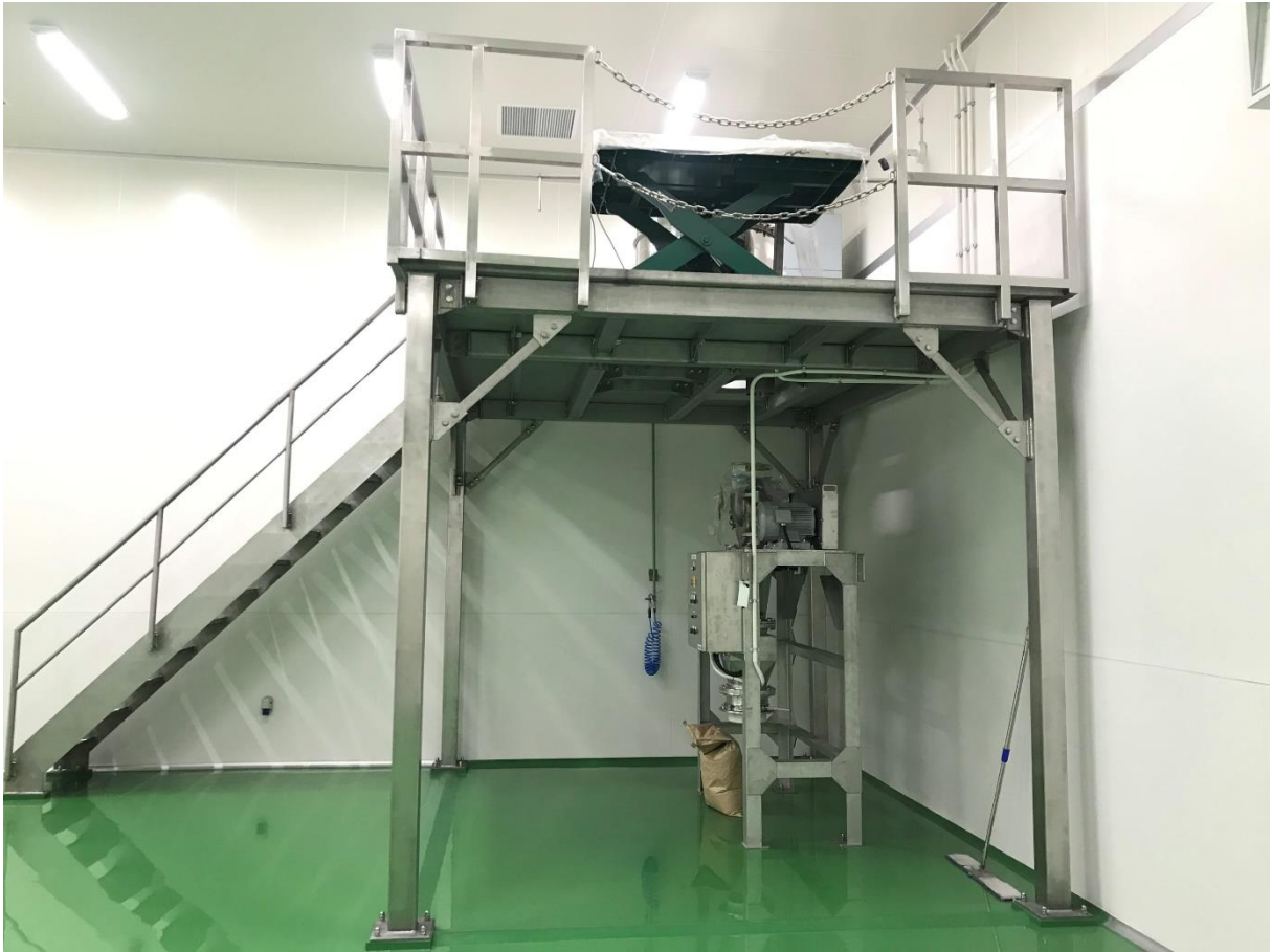
Hạng mục: Sàn khung máy – Dự án Nhà máy Nisshin Category: Machine frame floor - Nisshin factory project
