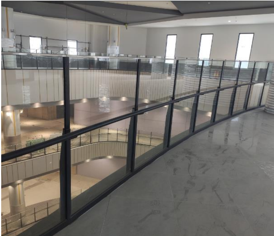
Hạng mục: Lan can kính – Dự án Aeon Mall Hà Đông
