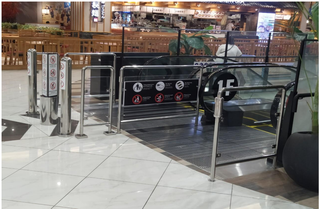
Hạng mục: Lan can bảo vệ thang cuốn – Dự án Aeon Mall Hà Đông
